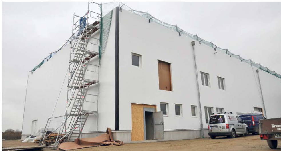
Kein Vergleich mehr zum Richtfest: Die Garnelenzucht „Neue Meere“ im Gewerbegebiet steht. Nun wird der Innenausbau vorangetrieben, um die Becken schnellstmöglich mit Salzwasser befüllen zu können, das gereinigt im Kreislauf verbleiben wird.
