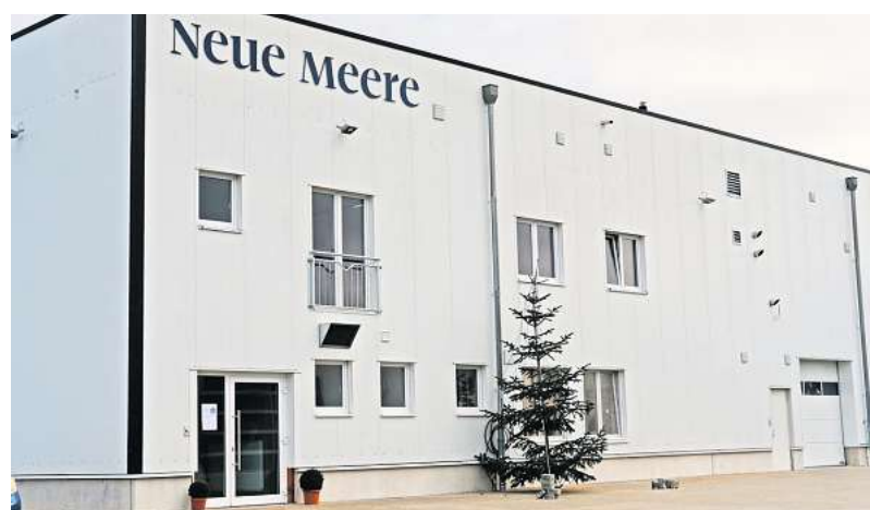
Unscheinbar: Der Firmensitz im Gewerbegebiet an der alten B 3.
