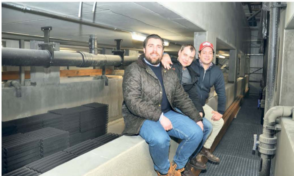
Die Gesellschafter Ludwig von Brockhausen (v.l.), Max Hoersen und Tarek Hermes begutachten regelmäßig den Baufortschritt und stehen in engem Austausch – auch mit dem Vierten im Bunde, Anwalt Philipp Hermes –, um den Prototypen für die Garnelen auf den Weg zu bringen.
