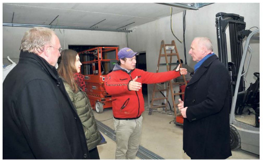
Die Baustelle zieht Besucher magisch an: Tarek Hermes bekommt regelmäßig Nachfragen, die er, wie hier Bundestagsabgeordnetem Bernd Westphal (r.), gerne beantwortet. FOTOS: HÜSING
